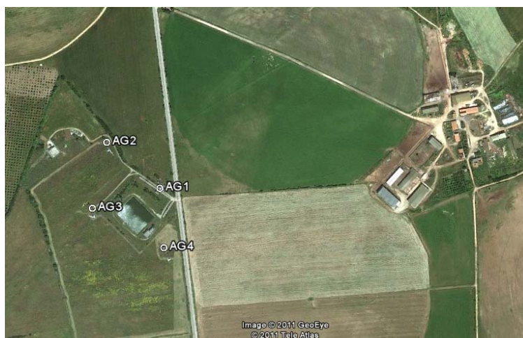
Impianto di Bancali
